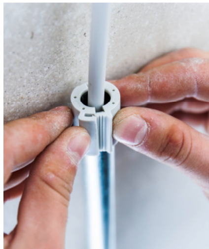
Bild: Mit der teilbaren Rohrendtülle gehört die aufwendige Nachinstallation der Vergangenheit an
