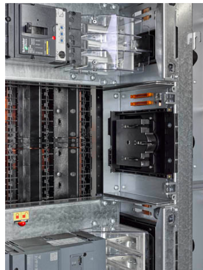
Bild Nr. 50-04 SC_SMU-Feld-offen.jpg. Führung des Steckmodules mit Kontaktierung und berührungssicherer Abdeckung im entnommenem Zustand.
