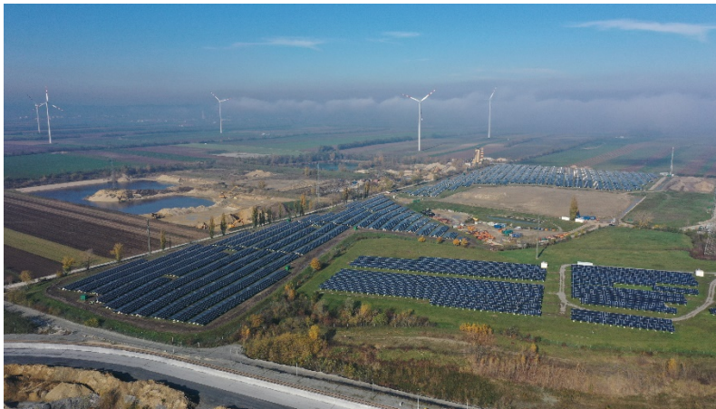
Blick von oben auf die größte Photovoltaik-Freiflächenanlage Österreichs Das Bild in druckfähiger Qualität finden Sie hier
