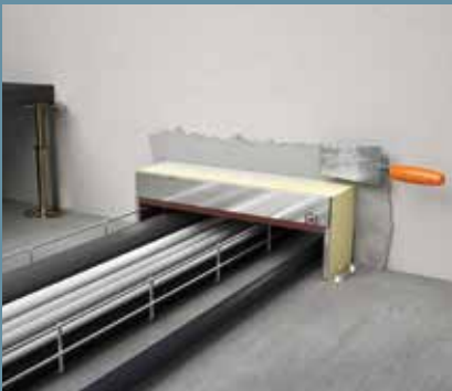
Sauberes Einmörteln der Box
