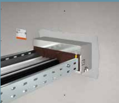
Potentialausgleich anschließen und Kennzeichnungsschild anbringen
