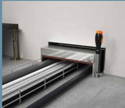
Einsetzen der Box in die Wandöffnung und Befestigung im Boden
