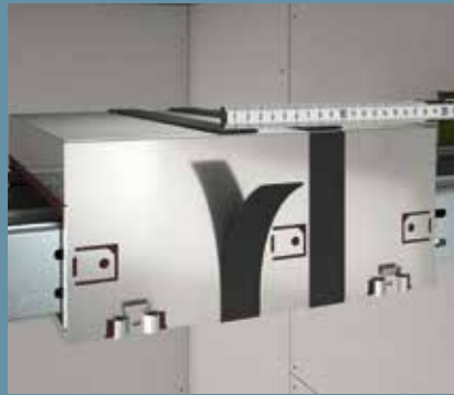
Wanddicke bemessen und Graphitstreifen in entsprechendem Abstand aufbringen
