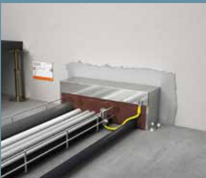
Potentialausgleich anschließen und Kennzeichnungsschild anbringen
