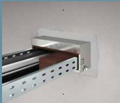
Zugeschnittenen Einlageblock in die größeren Leerräume einbringen
