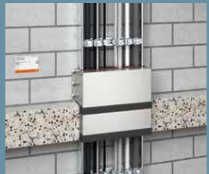
Variante als Deckenschottung über Steigetrasse
