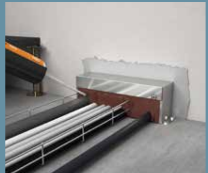
Zwischenräume mit PYROSIT® NG Brandschutzschaum komplett verschließen
