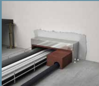
Zugeschnittenen Einlageblock in die größeren Leerräume einbringen
