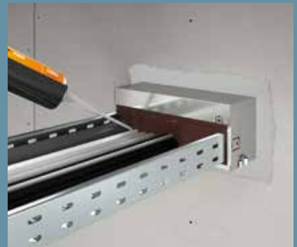
Zwischenräume mit PYROSIT® NG Brandschutzschaum komplett verschließen
